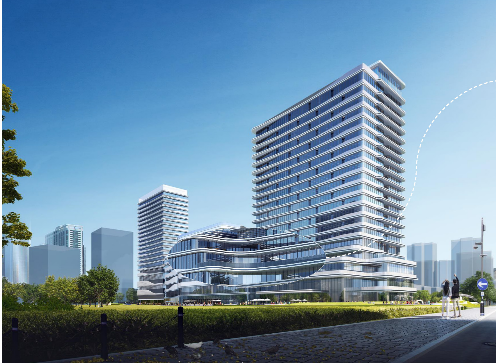
建筑周围横向凹槽内安装霓虹灯带
